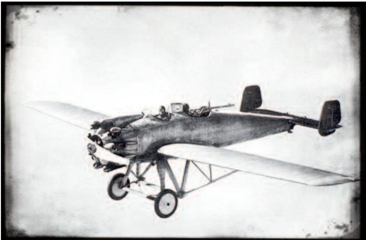
O K47 era uma aeronave de dois assentos modificada do padrão A48. O assento do observador era virado para a cauda e equipado com uma metralhadora giratória. Doze aeronaves foram fornecidas para a China, duas ou três para a Rússia e, provavelmente, uma para o Japão. Nenhuma versão armada foi adquirida pelos alemães, mas o avião original é parte fundamental no processo de desenvolvimento dos seus bombardeios de mergulho.
