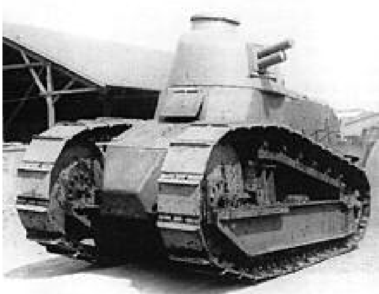
Mock-up do Renault FT, o ponto de inflexão que criou o moderno desenho de tanque. Note-se que as “armas” são pedaços de madeira. Autor e fonte desconhecidos. Cf. Jeudy, Jean-Gabriel, Chars de France . ETAI, 1997.
